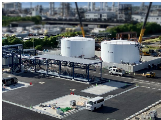
SAF の原料となる廃食用油受け入れ施設
