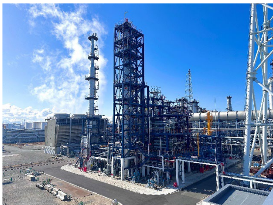
完工したSAF製造装置
