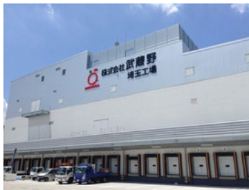
写真：左 株式会社武蔵野 埼玉工場
