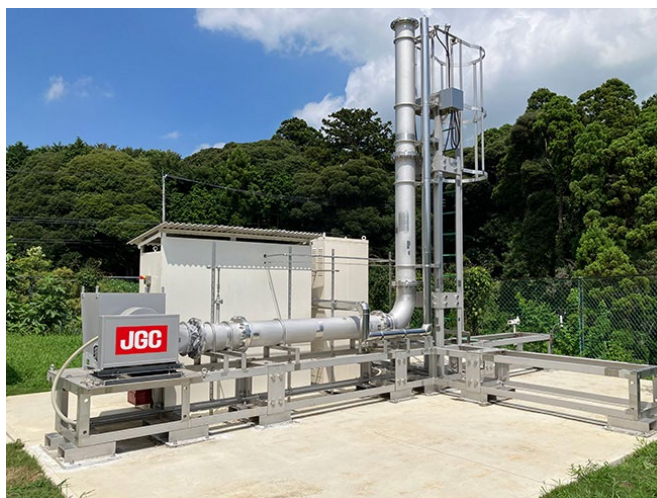
日揮 HD 技術研究所に建設したメタン排出計測技術評価設備
