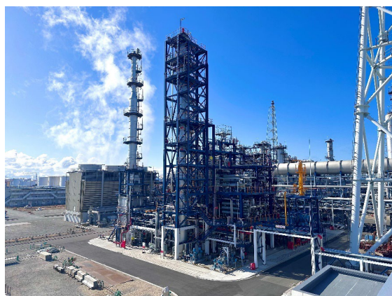
完工した SAF 製造装置 (コスモ石油堺製油所構内)
