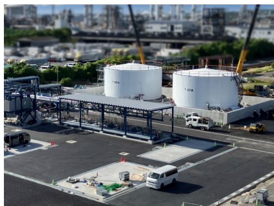
SAF の原料となる廃食用油受け入れ施設 (コスモ石油堺製油所構内)
