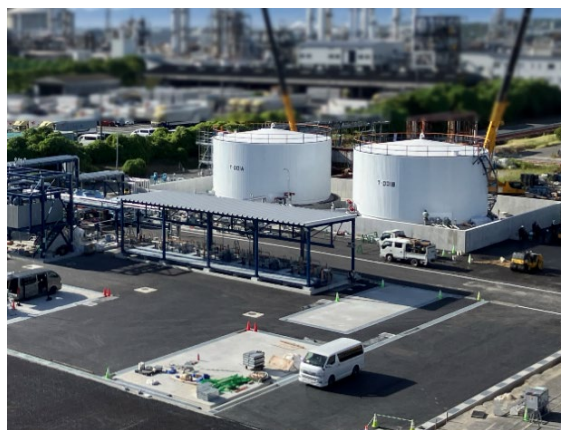
SAF の原料となる廃食用油受け入れ施設 (コスモ石油堺製油所構内)
