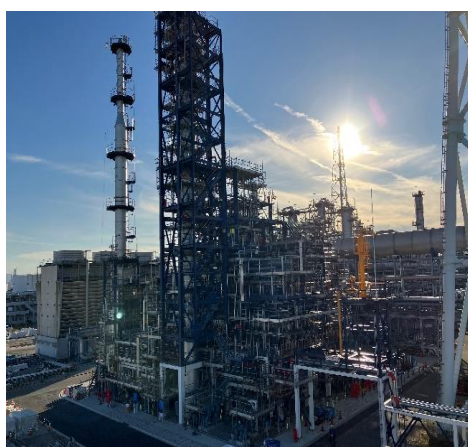
建設中の SAF 製造装置 (コスモ石油堺製油所構内)
