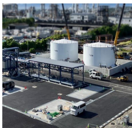
SAF の原料となる廃食用油受け入れ施設 (コスモ石油堺製油所構内)
