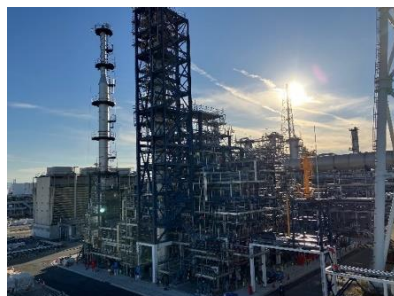
大阪府堺市に完成するSAF製造工場 (コスモ石油製油所構内)
