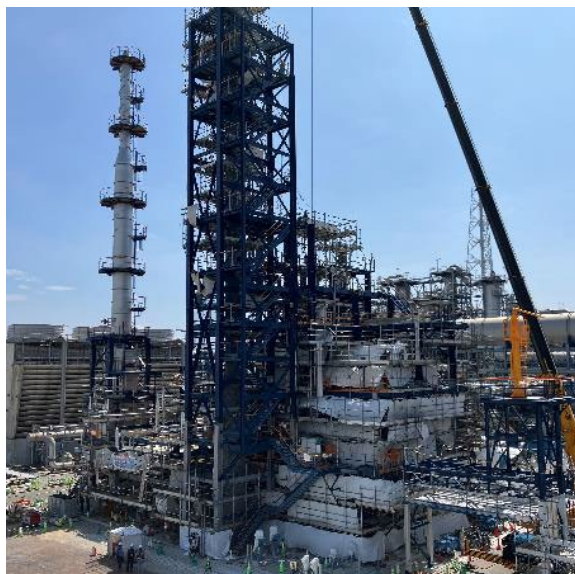
建設中の SAF 製造プラント
