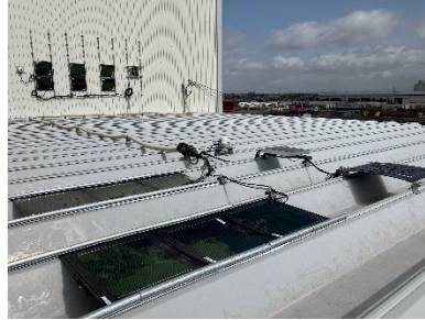
実証実験設備の取付状況
