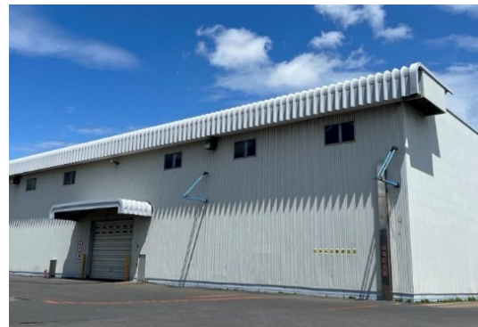
苫小牧埠頭の物流倉庫
