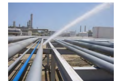
運転中の電縫管トラブル事例 （製品の品質問題にも具体的な対策を提案します）
