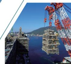
洋上や氷上など、極地で巨大プラントを建設するためのマネジメントが強みです。プラントを分割し、建設地とは離れた土地で事前に建造。最終建設地まで輸送した後、据付・統合を行うモジュール工法の実績をはじめ、大型構造物のハンドリングに関する豊富なノウハウを有しています。
