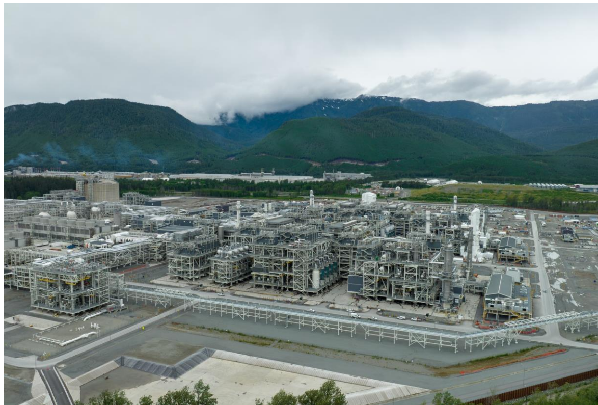
LNGカナダプラントの全景
