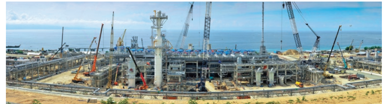
ドンギスノロLNG社向けLNGプラント(インドネシア) (建設中)
