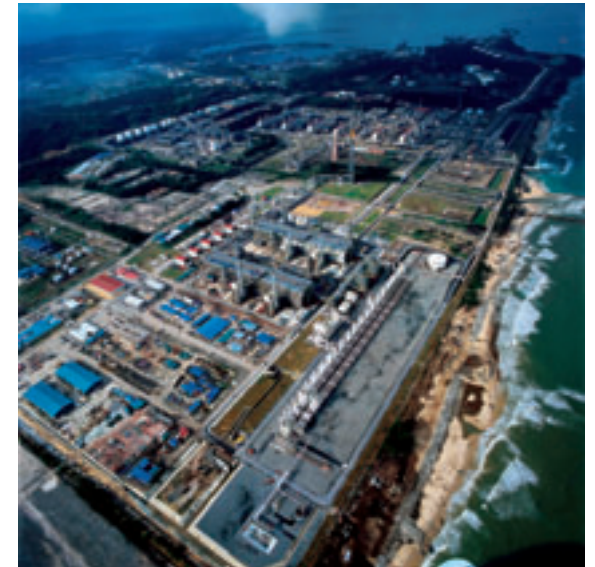
LNGプラント建設工事(マレーシア)
