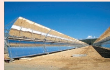
本太陽熱発電設備の集光ミラー (提供:Abengoa Solar社)
