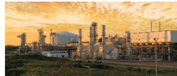
日揮が建設したインドネシアのLNGプラント
