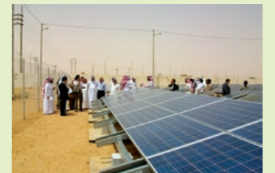
サウジアラビアでの太陽光発電実証設備
