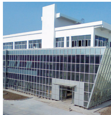
天津市の海水淡水化プラント
