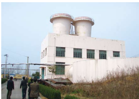
炭鉱 VAM ダクト
