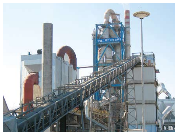
億利冀東水泥責任公司 セメント工場
