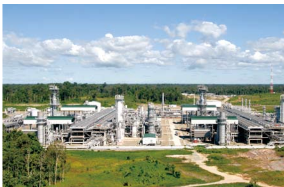
LNGプラント（インドネシア）
