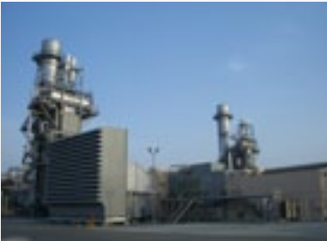
コージェネレーション設備
