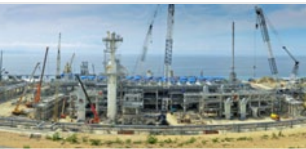
ドンギ・スノロLNGプロジェクト（インドネシア）（建設中）
