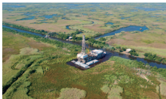
試掘1号井の掘削リグ(バーミリオン)
