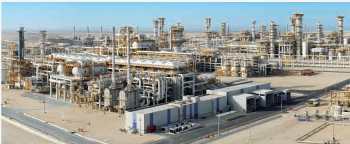
日揮がカタールで建設した大型ガス処理プラント
