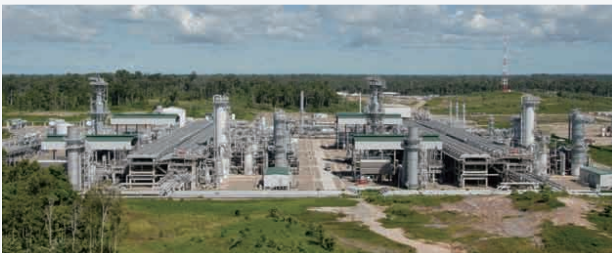
日揮がインドネシアで建設した大型LNGプラント
