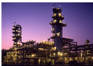
ガス処理プラント（サウジアラビア）
