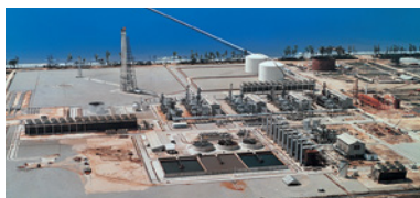
ブルネイLNGプラント
