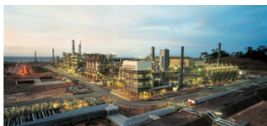
マレーシア大型商業GTLプラント
