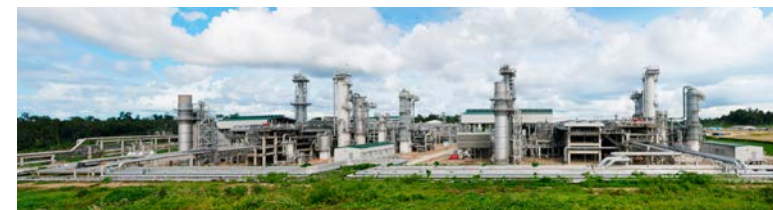
LNGプラント(インドネシア)
