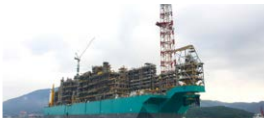
洋上LNGプラント(マレーシア)
