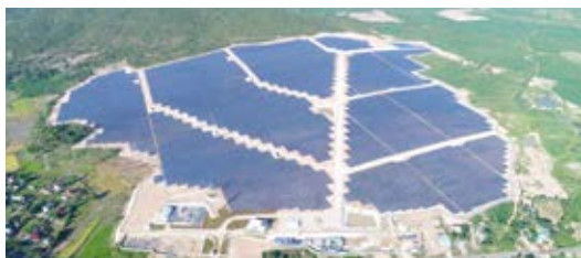
太陽光発電所(ベトナム)
