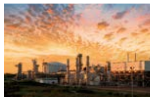
LNGプラント(インドネシア)
