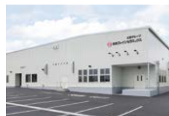
増産のための設備投資が決定した高熱伝導窒化ケイ素基板の生産工場
