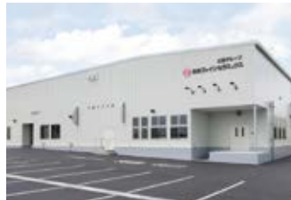
増産のための設備投資が決定した高熱伝導窒化ケイ素基板の生産工場
