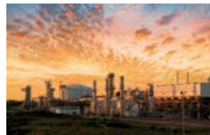
LNGプラント（インドネシア）
