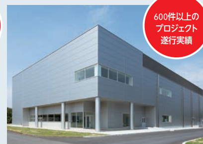
医薬品製造プラント
