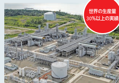
LNG プラント
