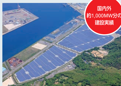
太陽光発電所
