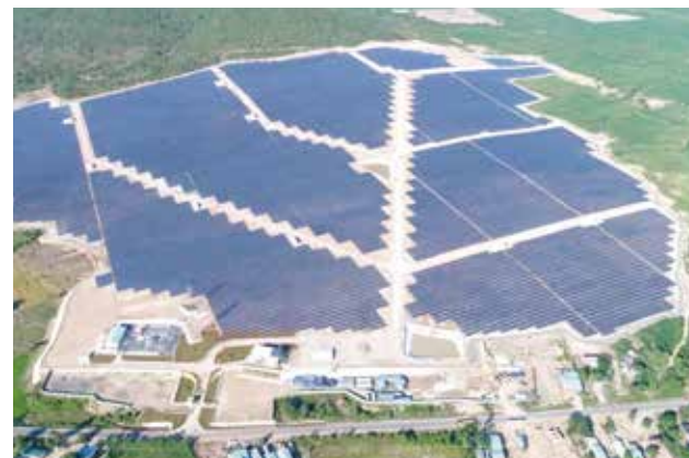
ザライ電力合弁会社向け太陽光発電所
