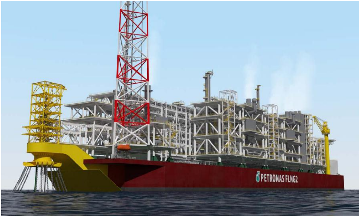
Floating LNG Plant
