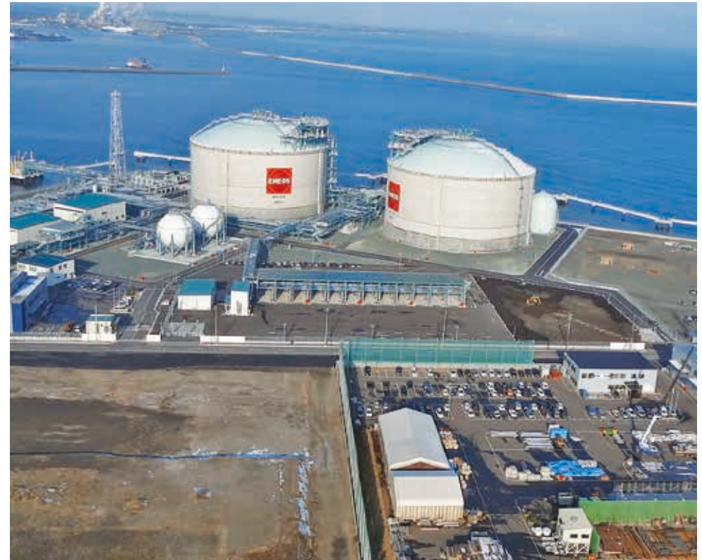
LNG Terminal (Japan) Supplied by JX Nippon LNG Service Company, Limited
