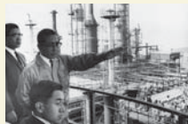
ペルーの製油所建設現場を 視察された明仁皇太子殿下（当時） The Crown Prince (Emperor Akihito) visiting a refinery under construction in Peru
