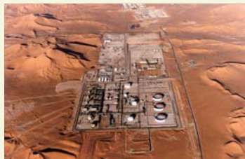
アルジェリアの原油処理プラント Crude oil processing plant in Algeria
