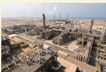
サウジアラビアの石油精製・石油化学統合コンプレックス Refining and petrochemical complex in Saudi Arabia
