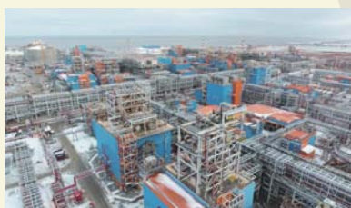
ロシアの LNG プラント LNG plant in Russia
