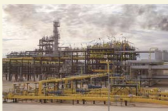
アルジェリアのガス集積・分離プラント Gas processing plant in Algeria
