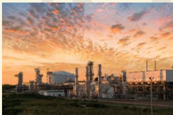
インドネシアのLNGプラント LNG plant in Indonesia
