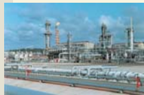
マレーシアの LNG プラント LNG plant in Malaysia
