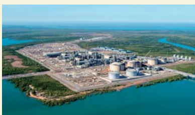
オーストラリアの LNG プラント LNG plant in Australia
