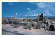
タイの製油所 Refinery in Thailand
