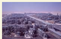
サウジアラビアのガス処理プラント Gas processing plant in Saudi Arabia
