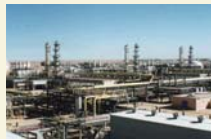
アルジェリアの天然ガス処理プラント Gas processing plant in Algeria
