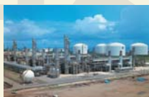
インドネシアの LNG プラント LNG plant in Indonesia
