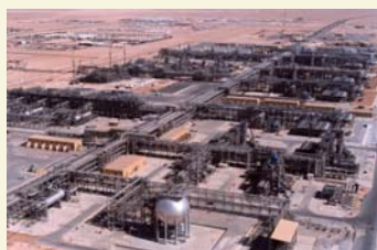
サウジアラビアのガス処理プラント Gas processing plant in Saudi Arabia
