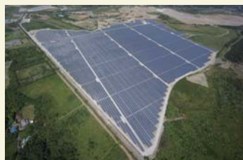
千葉県の大規模太陽光発電所 Mega-solar power plant in Chiba, Japan
