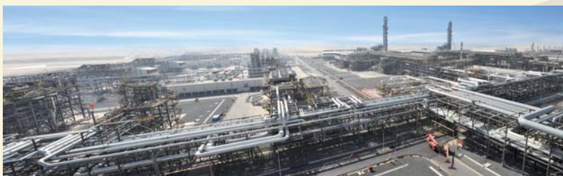
アラブ首長国連邦のガス処理プラント Gas processing plant in UAE
