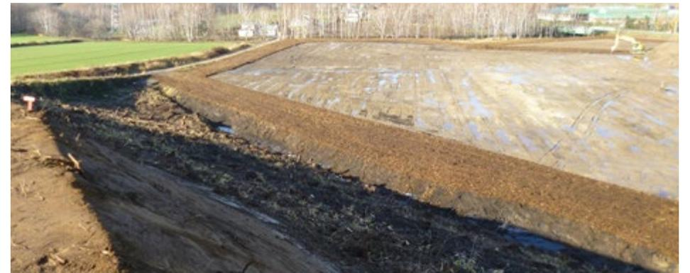
当社グループの日揮プラントイノベーションでは、伐採材を有効活用した「ウッドチップ舗装」を提案し、建設現場に導入しています。北海道にある小清水太陽光発電所は、オホーツク海側の気候で比較的降雪量が少ないとはいえ、風は強く、凍結深土は80cmにもなります。建設地の土質特性として多くは粘土質地盤のため水はけが悪く、車両通行が困難な場所であり、表土改良すれば改善されるものの導入コストが高く、現実的ではない状況でした。そこで、日揮プラントイノベーションは伐採材をチップ処理した材料を再利用して走行路に敷き詰め、現状の水はけが悪い地盤を改良し、車両の走行を可能にしました。(チップ処理実測堆積：約5,000m<sup>3</sup>、推定伐採量：約30,000m<sup>3</sup>)
