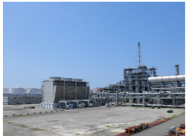
建設予定地写真
