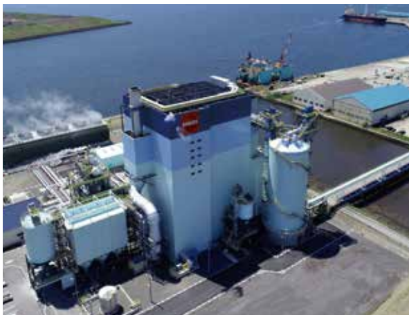
バイオマス発電プラント(日本)
