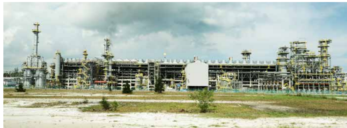
Bintulu LNG Complex, Malaysia (train 9)
