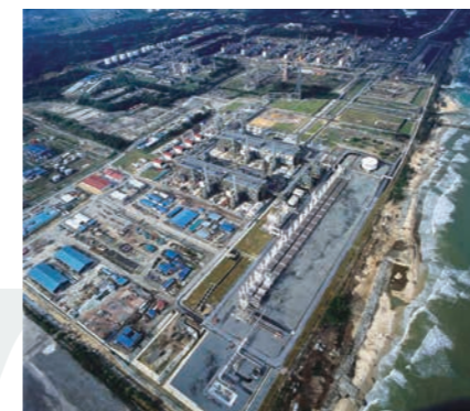
LNG plant for Malaysia
