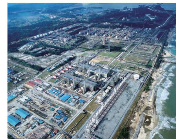
Malaysian LNG complex
