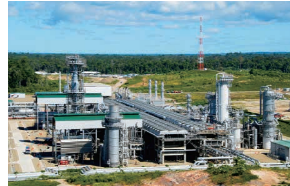
Tangguh LNG Plant in Indonesia
