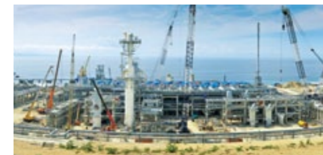
Donggi-Senoro LNG project (Indonesia)
