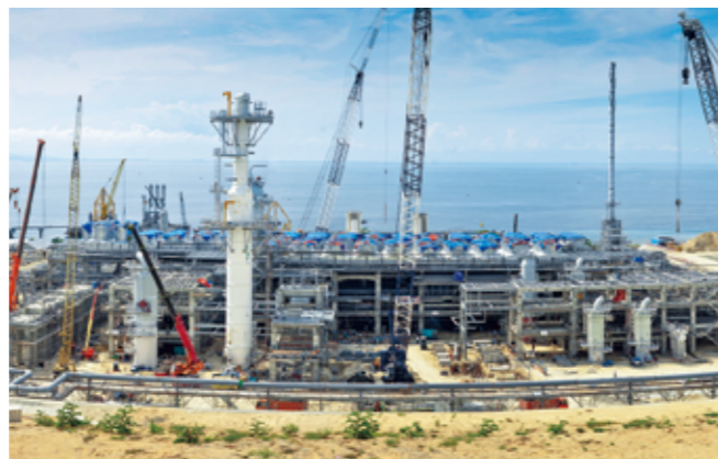
An LNG plant under construction for Sulawesi LNG Development (Indonesia)
