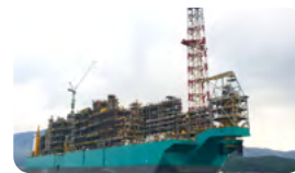
Floating LNG plant (Malaysia)
