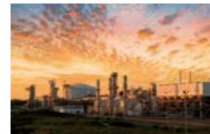
LNG plant (Indonesia)
